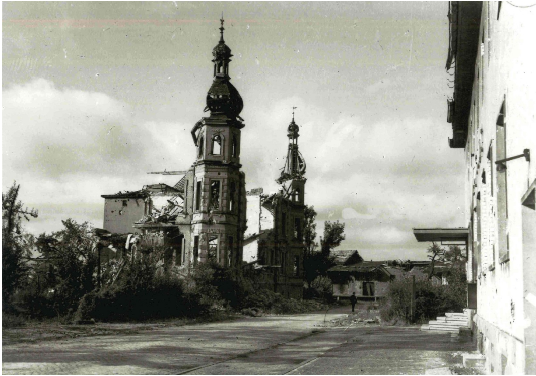
Das zerstörte Wohnhaus der Familien Haas, im Hintergrund die Gebäude der Furnierhandlung. Im Vordergrund die 1946 wieder aufgebaute Post. 82
