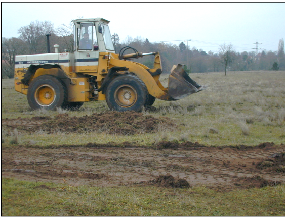
Abbildung 7.3: Flaches Abschieben
