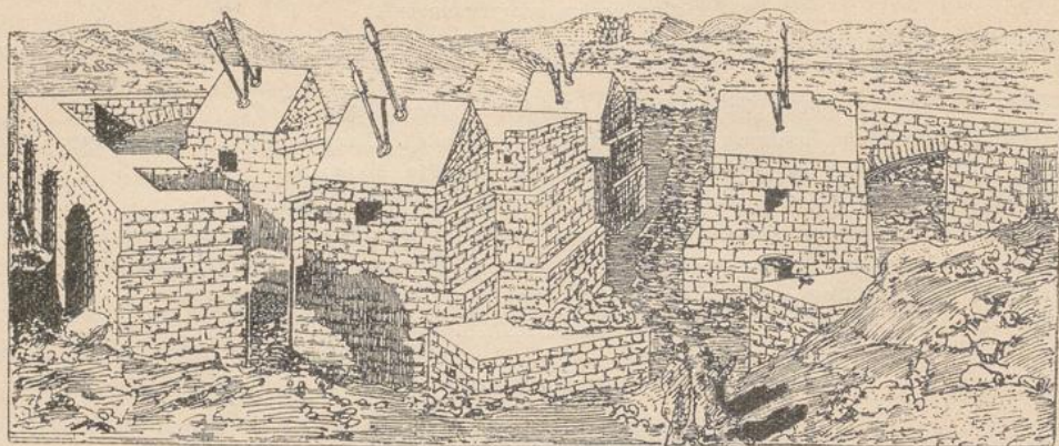
Blick auf die Fundamente eines Eckpfeilers 286) .
