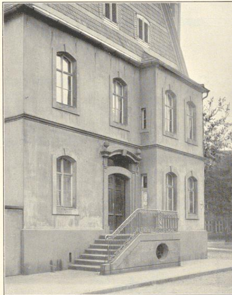
Evangelisches Pfarrhaus, Langenstrasse 69. Renaissance, 19. Jahrhundert. Mit Erker und Freitreppe.
