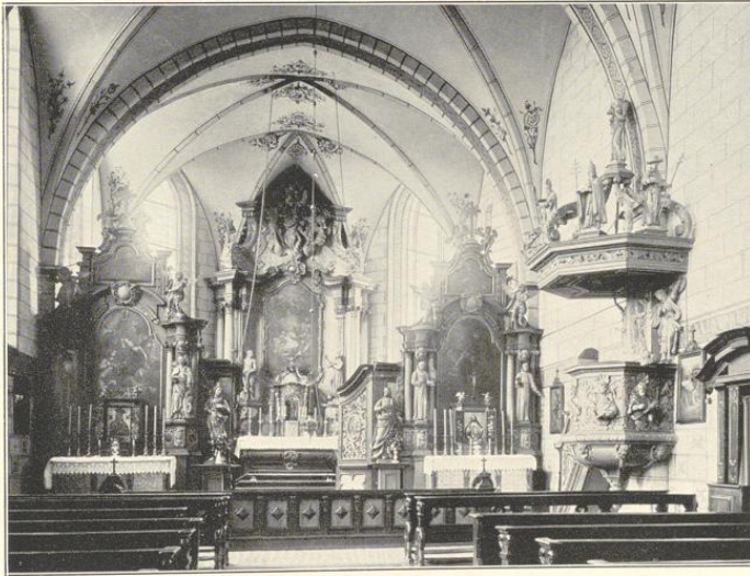
Innenansicht nach Osten.
