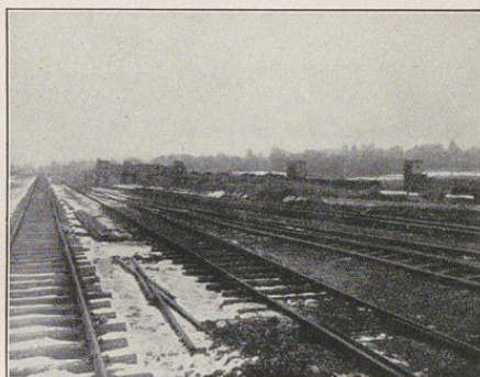
Ausbau des Bahnhofes Kiel-West
