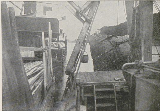
Abb. 2. Autogen unter Wasser ausgeschnittenes Schiffswandstück
