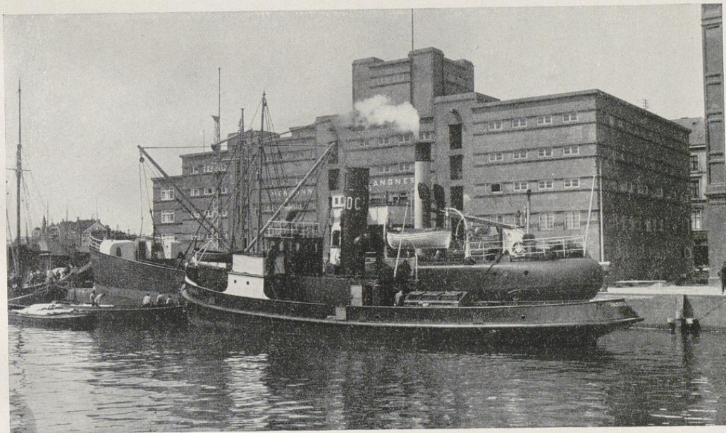
Speicherbau am Sartorikai — Arch. Stoffers — Phot. Petersen
