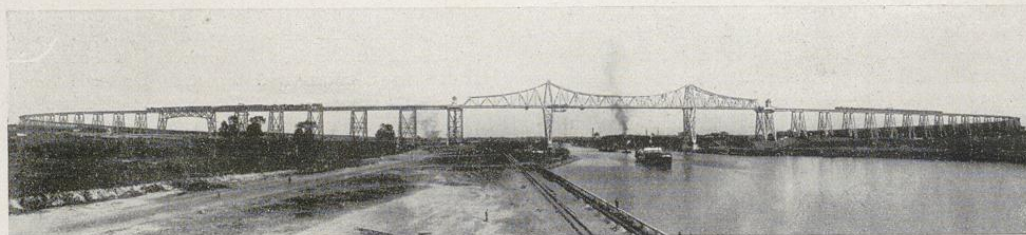
Kaiser-Wilhelm-Kanal, Rendsburger Hochbrücke — Phot. Kanalamt
