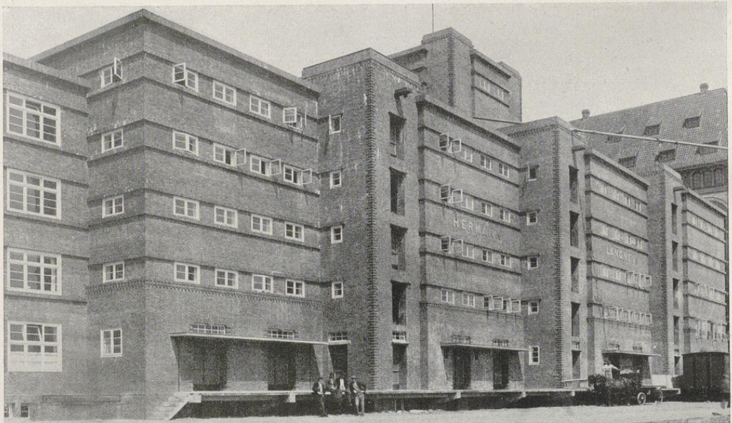
Speicherbau der Stadt gemeinsam mit der Firma Langness am Sartorikai — Arch. Stoffers — Phot. Rohwer
