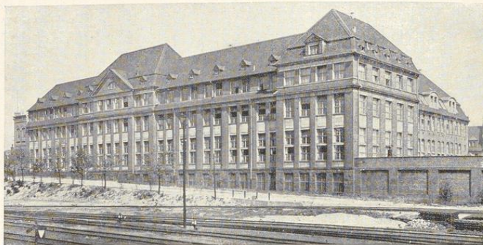
Das Essener Gebäude des Verlags W. Girardet
