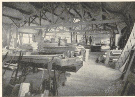
Werkstatt für einfachere Bauarbeiten
