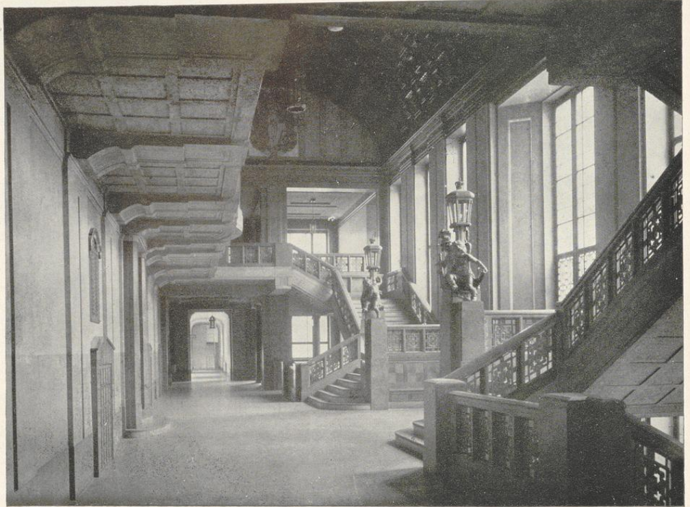
Treppenaufgang Justizgebäude (Arch. Staatl. Hochbauverwaltung)
