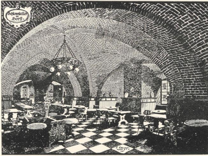
Teilansicht des Schloßkellers, Originalgewölbe aus den 14. Jahrhundert
