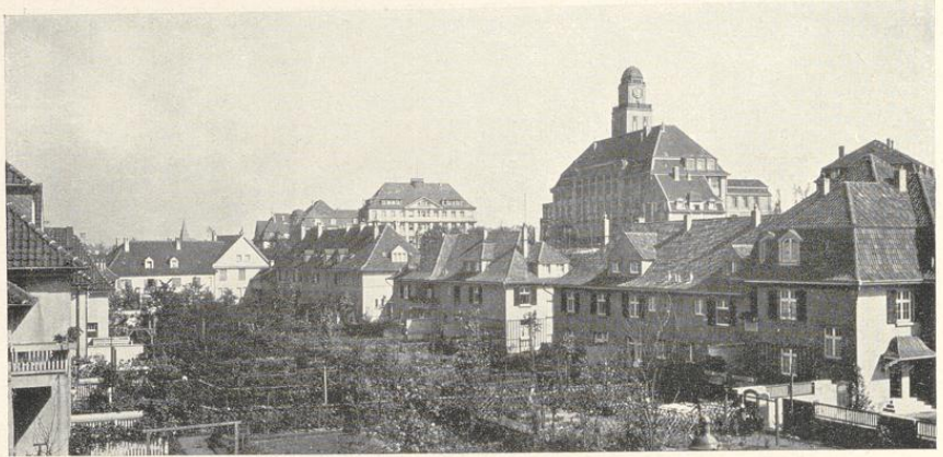
Siedlung des Bauvereins Eigenheim
