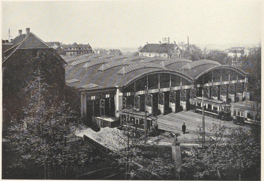
Abb. 1. Wagenhalle Essen-Bredeney. Außenansicht
