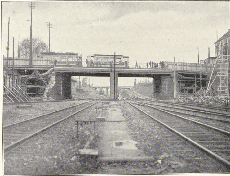
Abb. 1. Rüttenscheider Brücke. Beginn des Umbaus
