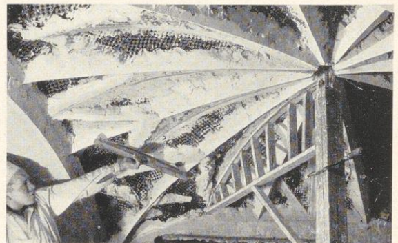
Bild 991. Anlegen der Kehllehren mit dem Flügel, die Zwischengrate werden von Hand herausgezogen
