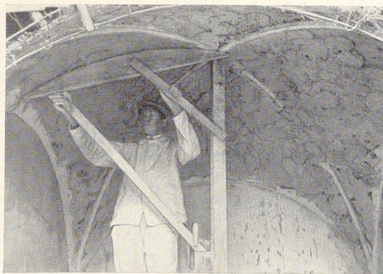
Bild 986. Grundieren der Gewölbefläche einer Stutzkuppel mit dem drehbaren Flügel
