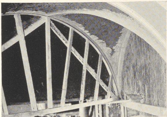
Bild 933. Anlegen der Gipslehren mit Hilfe des Lehrbogens
