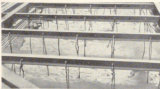
Bild 723. Abhängerbefestigung an durchbohrten eisernen Trägern
