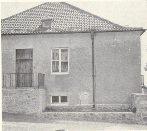
Bild 297. Zerstörung des Farbanstrichs durch Witterungseinflüsse. Die Farbe besitzt keine Bindung mit dem Verputz
