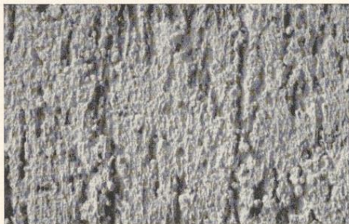
Bild 223. Scheibputz, senkrecht verrieben
