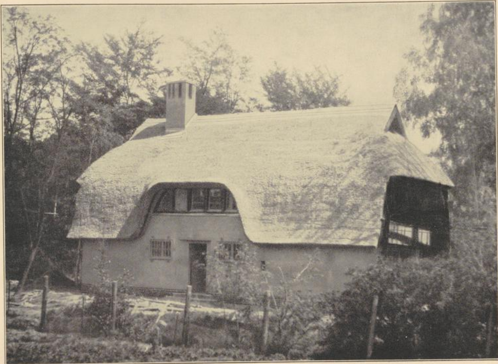
Landhaus in Ferch. Rohrdeckung.
