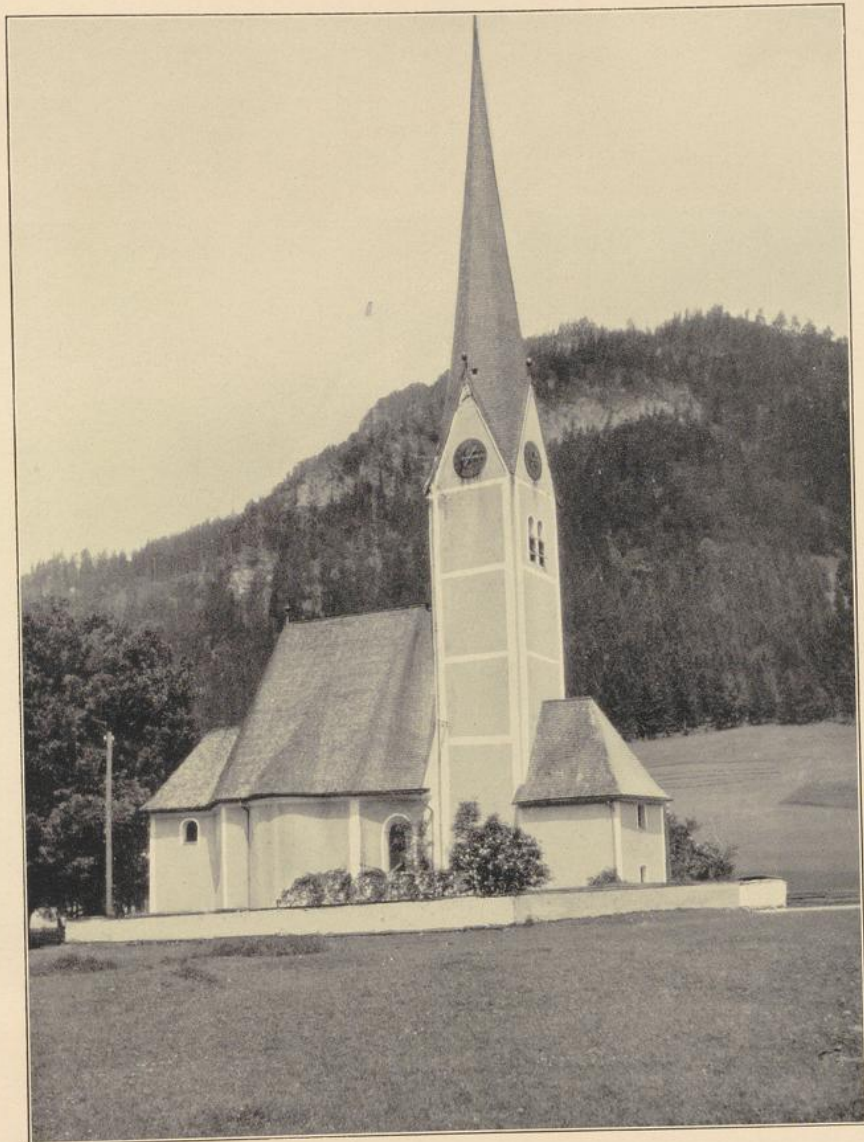
Kirche in Neuhaus. Schindeldeckung.
