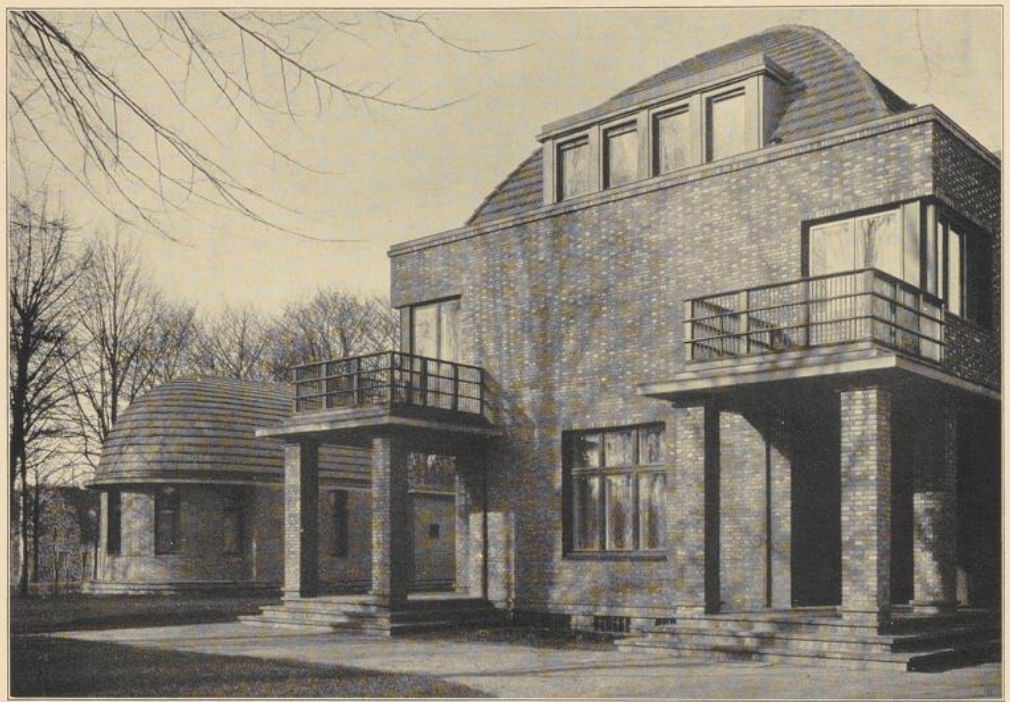
Haus eines Komponisten in Hamburg. Biberschwanz-Kronendeckung.
