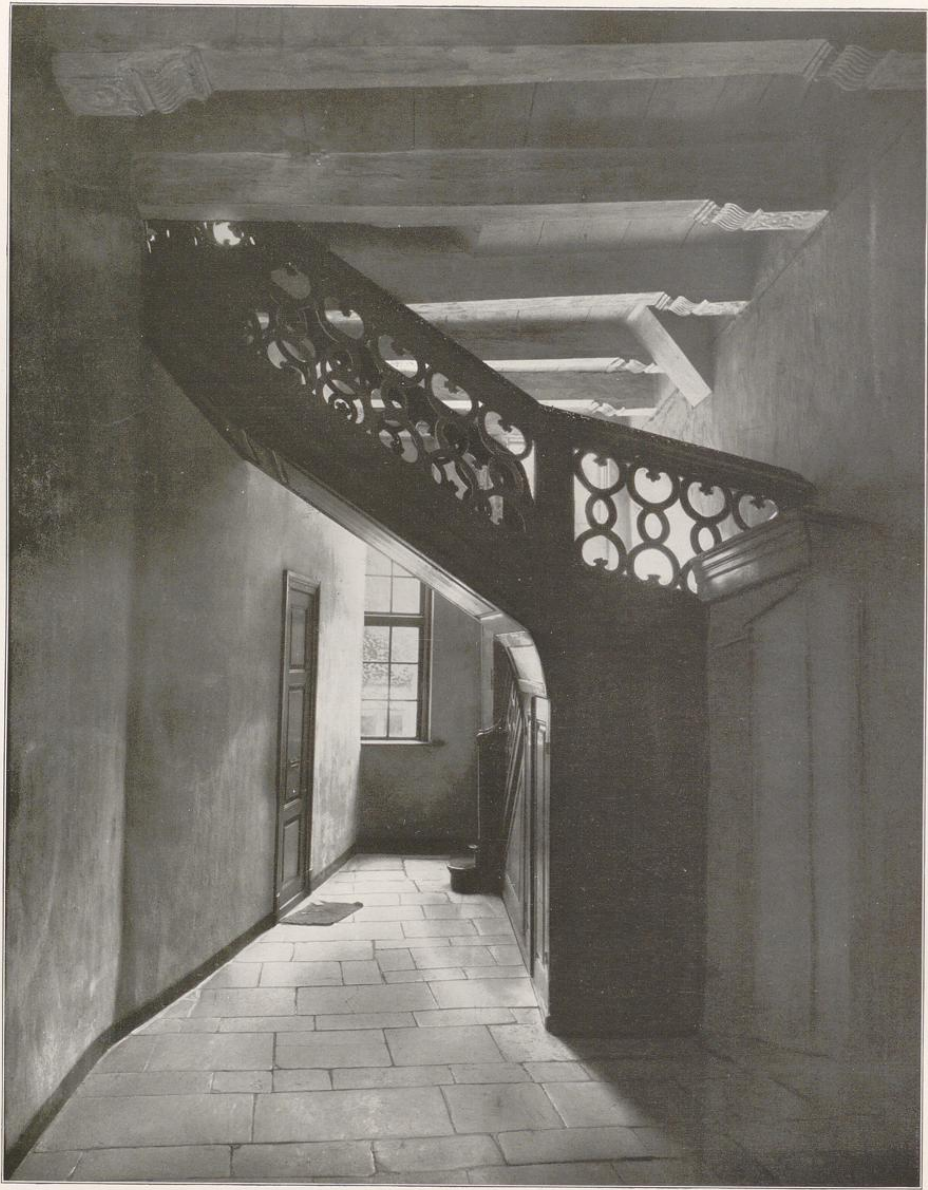
Kiel — Treppe zum Saal im Haus „Stadt Kopenhagen“, Schuhmacherstraße 24.
