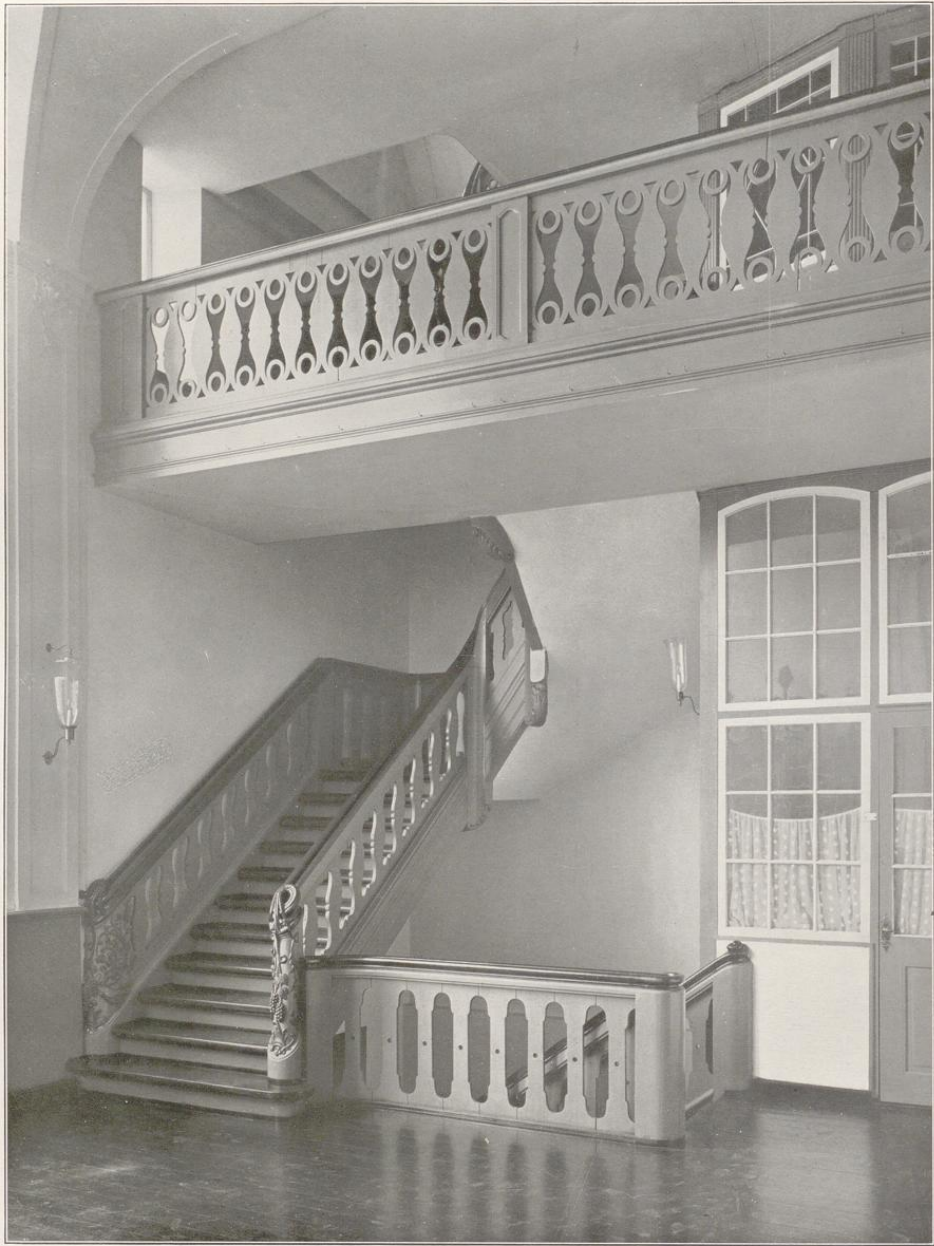
Lübeck, Schabbelhaus — Treppeneinbau.
