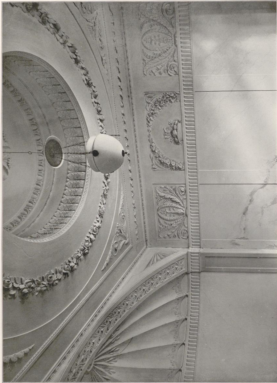
Flensburg — Stuccodekoration in dem Gartenzimmer eines Hauses am Holm um 1820.
