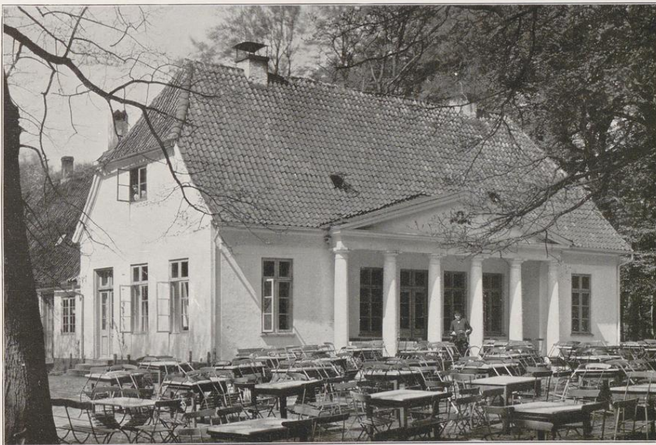
Flensburg — Wirtschaftsgebäude in Marienholz. Anfang 19. Jahrh.
