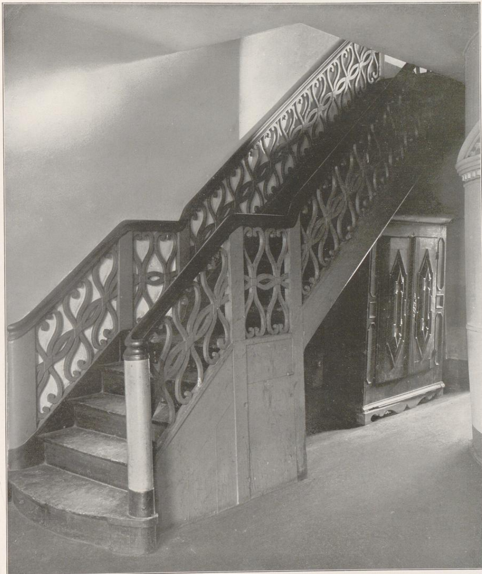
Hadersleben — Treppenhaus in der Badstubenstraße, Ende 18. Jahrh.
