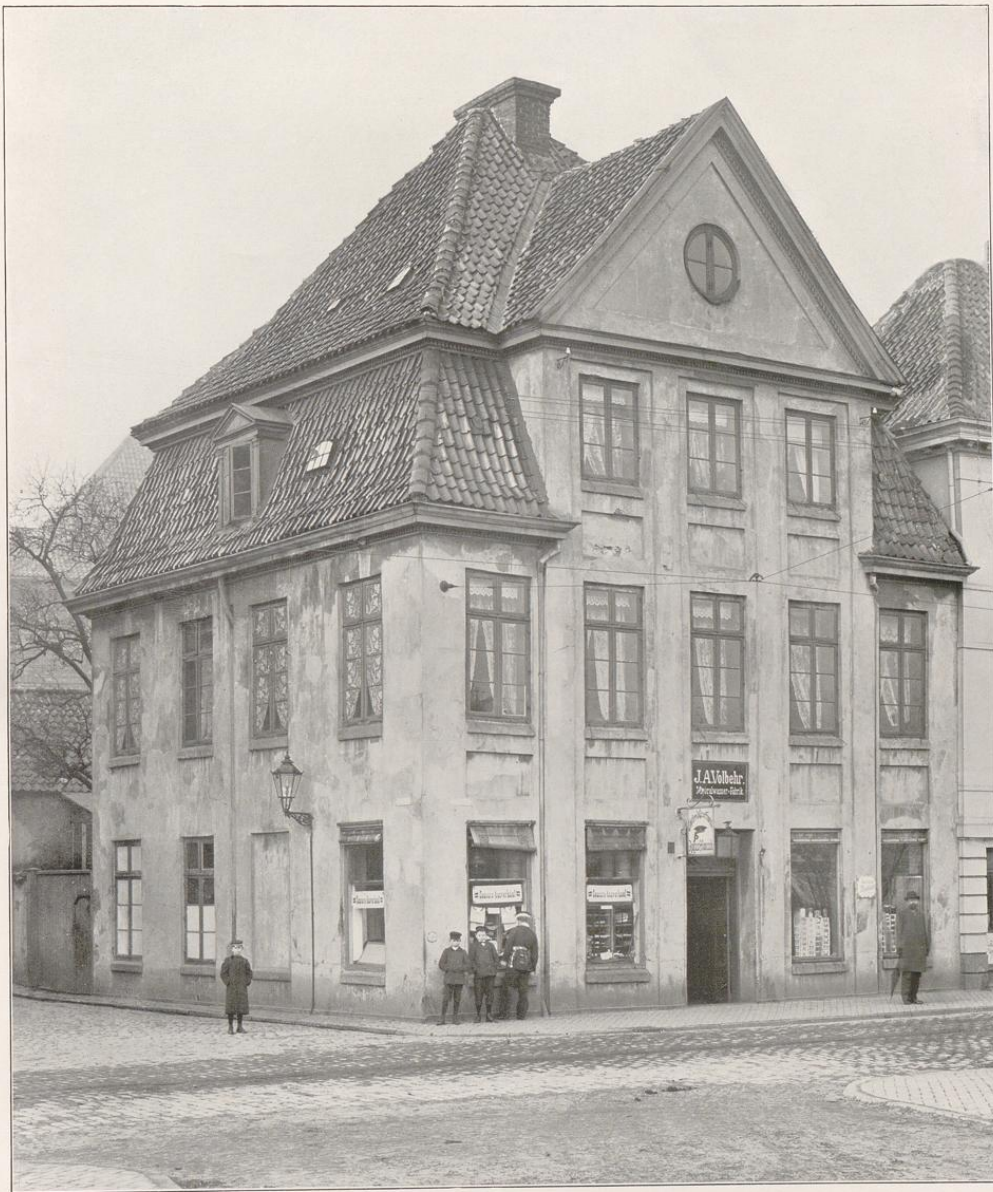
Kiel — Haus Ecke Wall- und Kattenstraße, 18. Jahrh. (abgebrochen).
