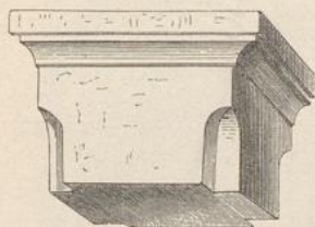
Fig. 87. Abgefaßter Pfeiler. Kirche zu Gernrode.
