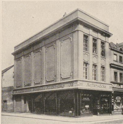
Abb. 151. — u. nach dem durch die Bauberatung beeinflussten Umbau.
