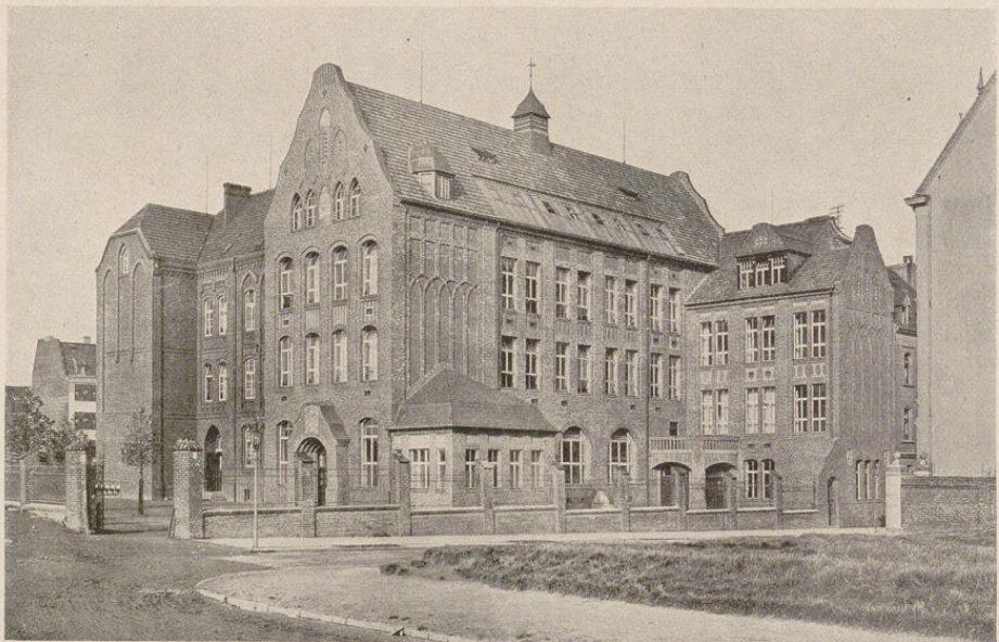
Abb. 73. — Bonifatiuschule an der Hagenstr. Alter Teil links von Arch. Düchting u. Jänisch, neuer Teil rechts von Stadtbausp. Uhlig.
