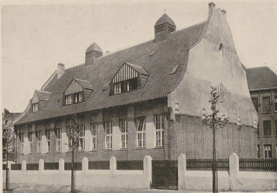
Abb. 71. — Turnhalle der Aloysiusschule an der Langestraße.
