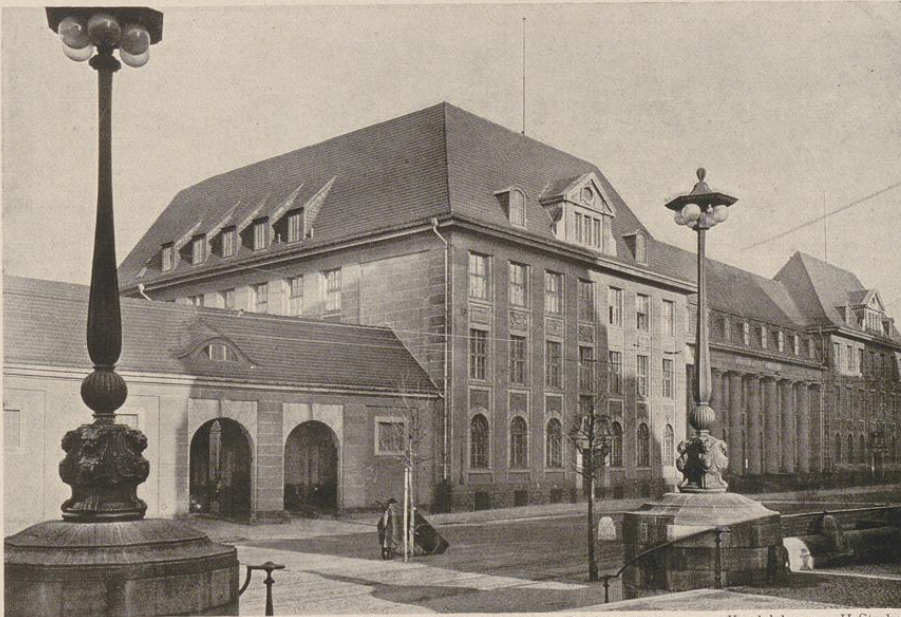
Abb. 79. — Hauptpostgebäude; erbaut 1910/11 von Geh. Baurat Buddeberg-Berlin, Reichspostamt.
