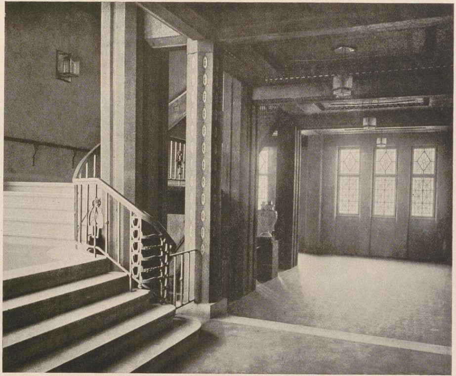
Abb. 66. — Treppenhalle in der Handwerker- und Kunstgewerbeschule.
