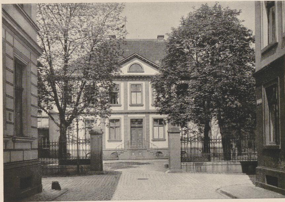
Abb. 32. — Haus Meininghaus, II. Kampstr. Nr. 15; erbaut um 1810.
