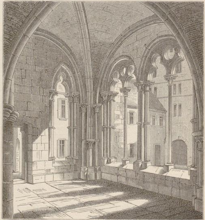
Fig. 134. Vorhalle in Kloster Maulbronn. (Nach C. Nieß.)
