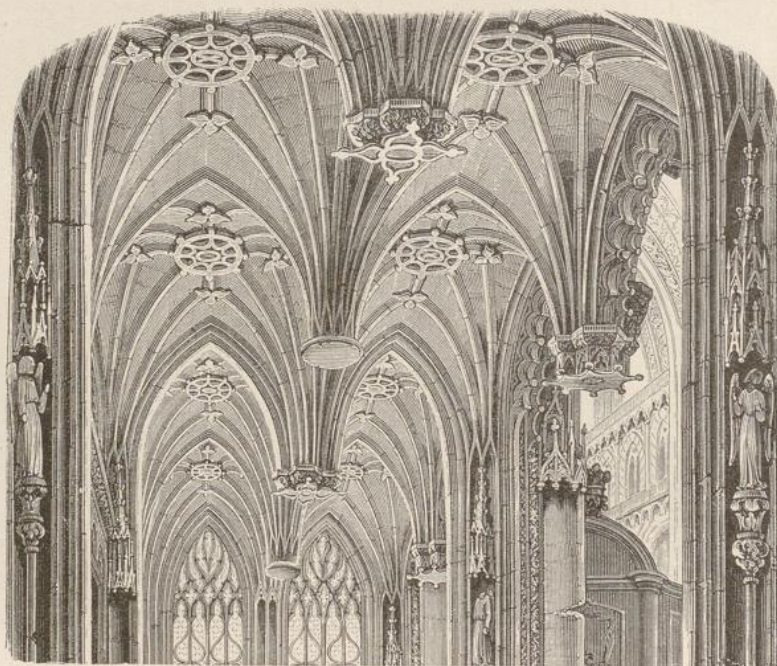
Fig. 231. Gewölbe der Kathedrale zu Amiens, mit hängenden Schlusssteinen.
