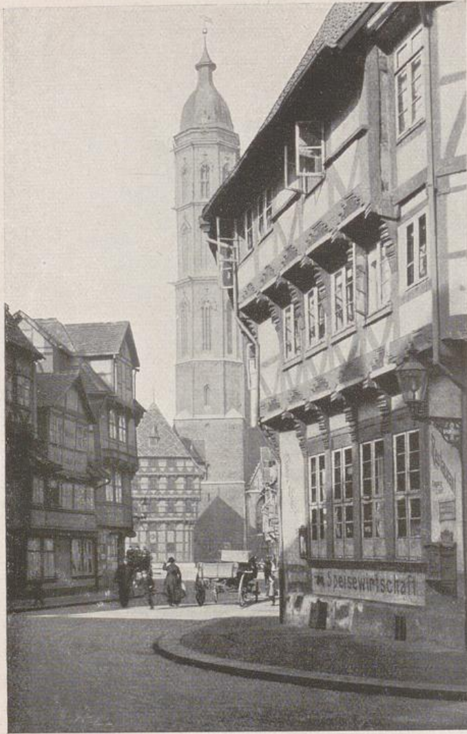
Blick vom Meinhardshof auf den Andreaskirchturm
