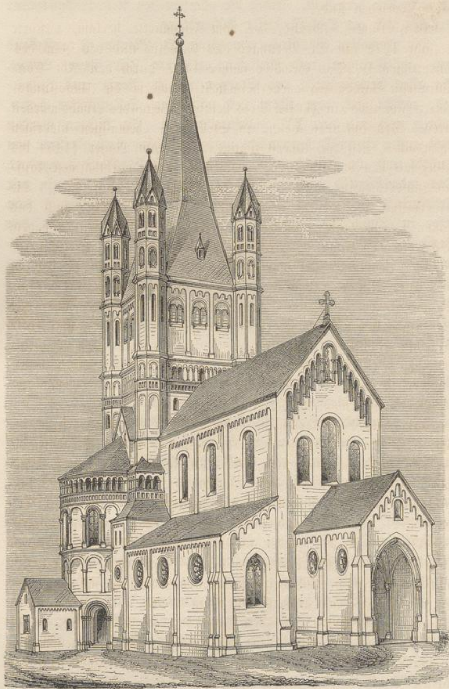
Fig. 4. Ansicht der Nordseite der Kirche Groß St. Martin zu Köln.
