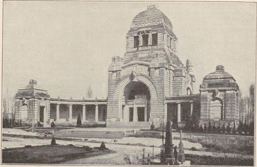
Fig. 7. Stuttgarter Krematorium: Hauptfachaufseite.
