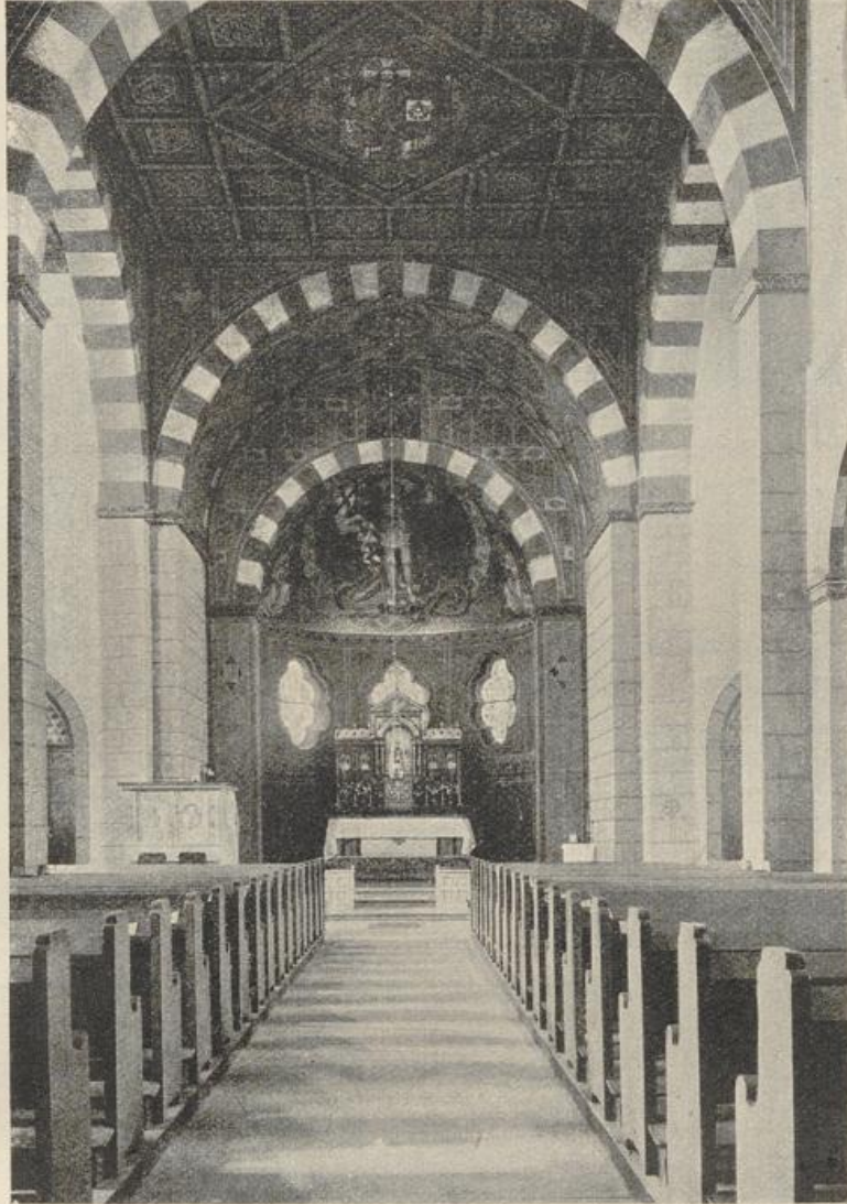
Abb. 360. Katholische Kirche in Brockau bei Breslau. Blick nach dem Altar.
