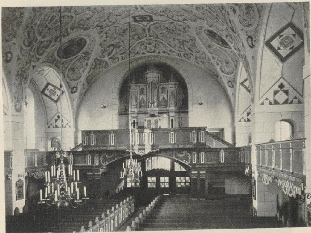
Abb. 187. Posen-Wilda, Inneres. Blick nach dem Eingange.
