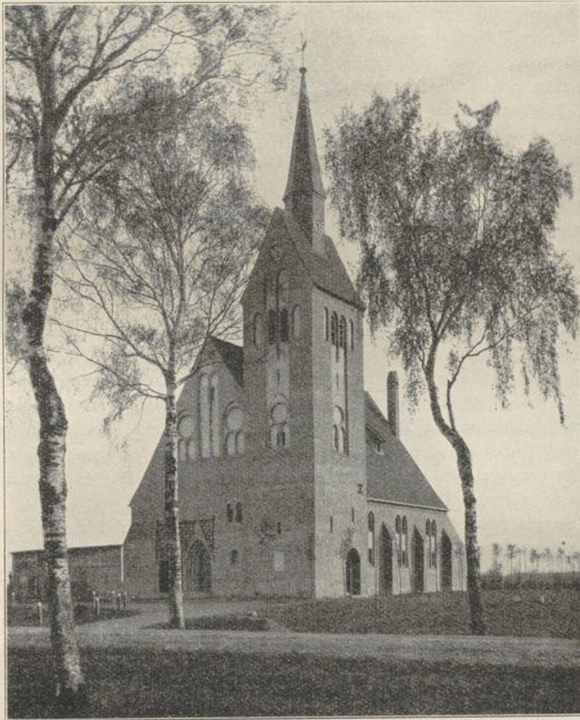
Abb. 146. Kirche in Groß-Schorellen. Ansicht.
