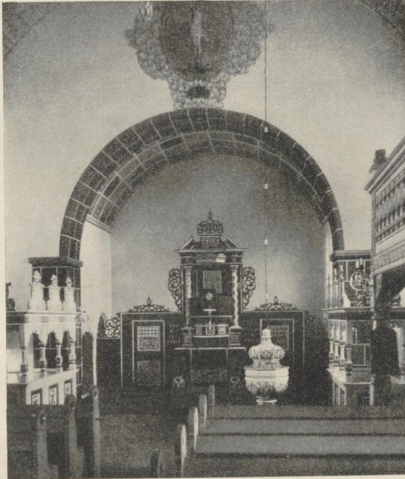
Abb. 89. Kirche in Greppin. Blick gegen den Altarraum.
