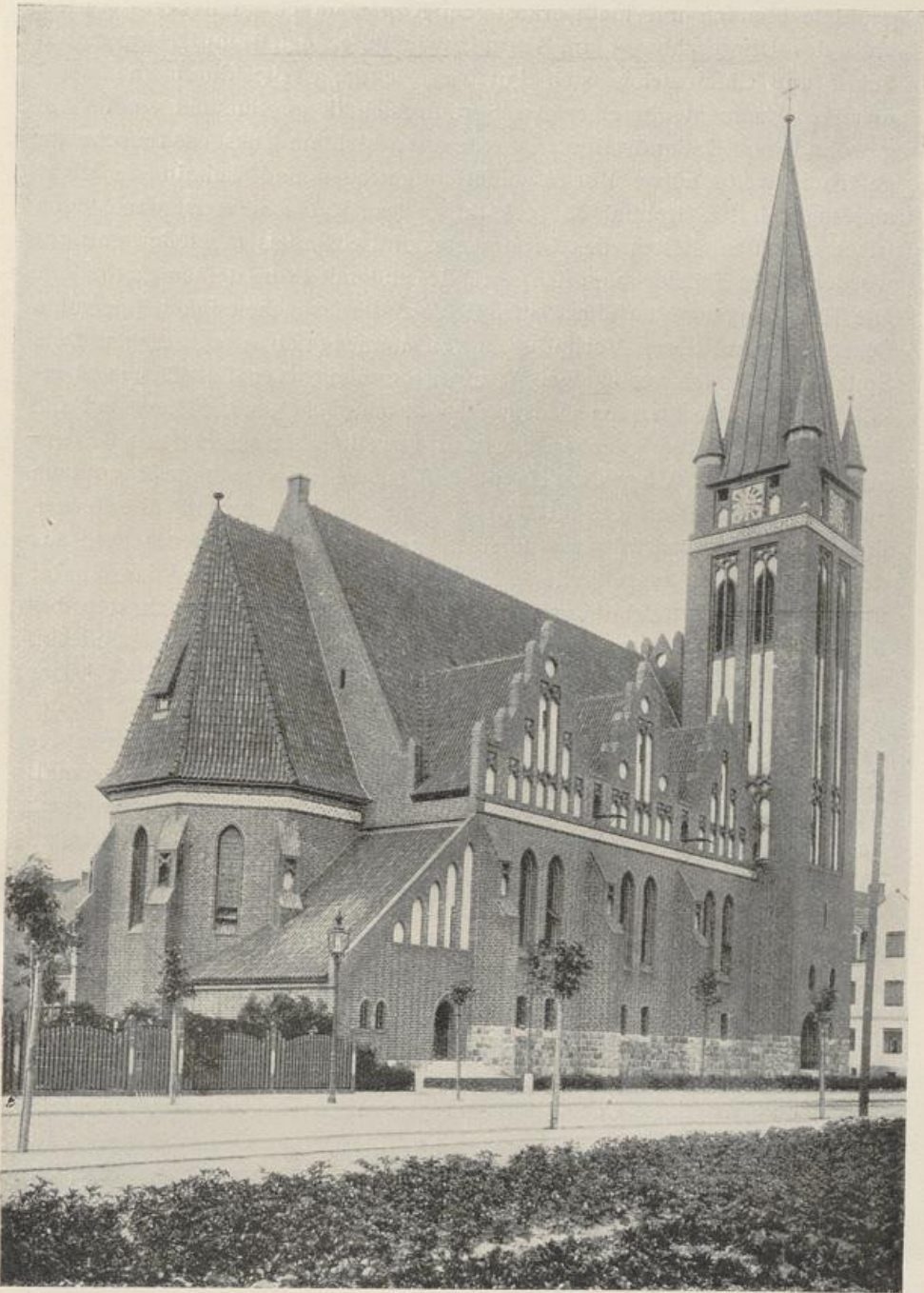
Abb. 162. Südwestansicht. Evangelische Kirche in Schneidemühl.
