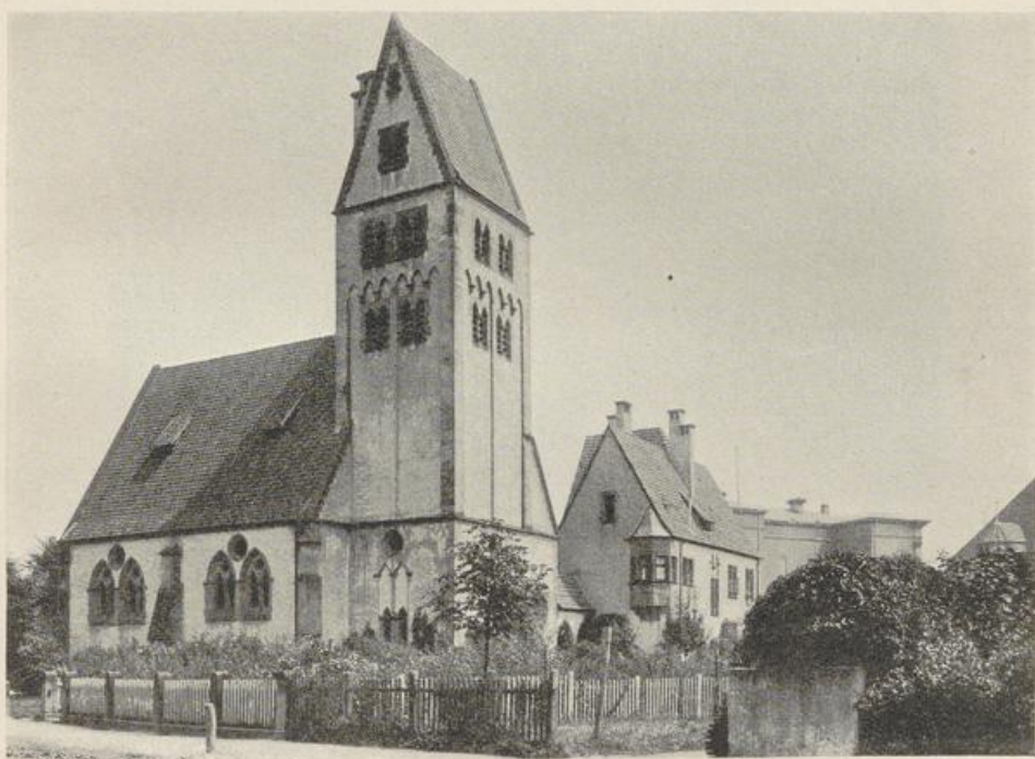
Abb. 266. Ansicht von Westen.
