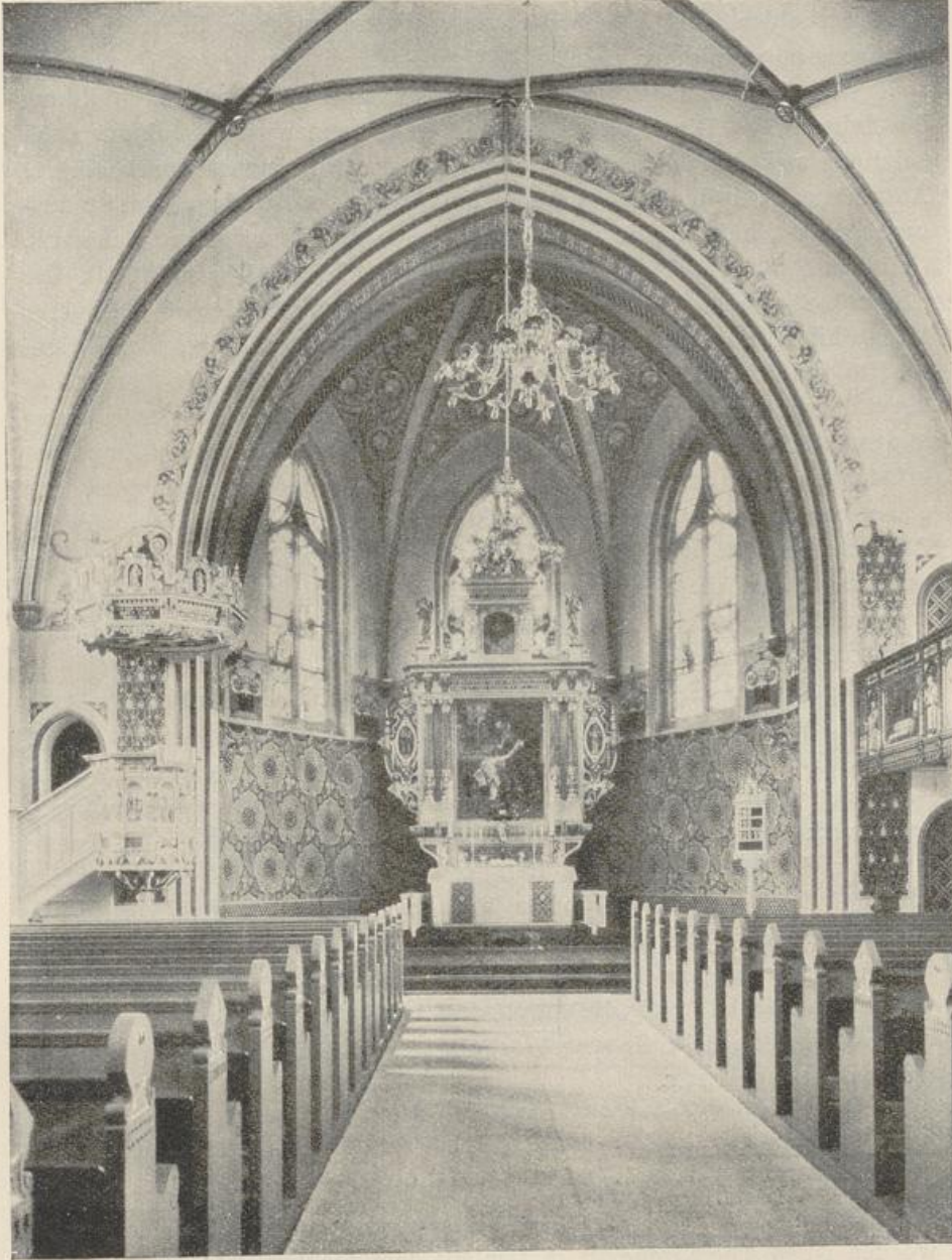
Abb. 236. St. Jürgenkirche in Flensburg. Blick in den Altarraum.
