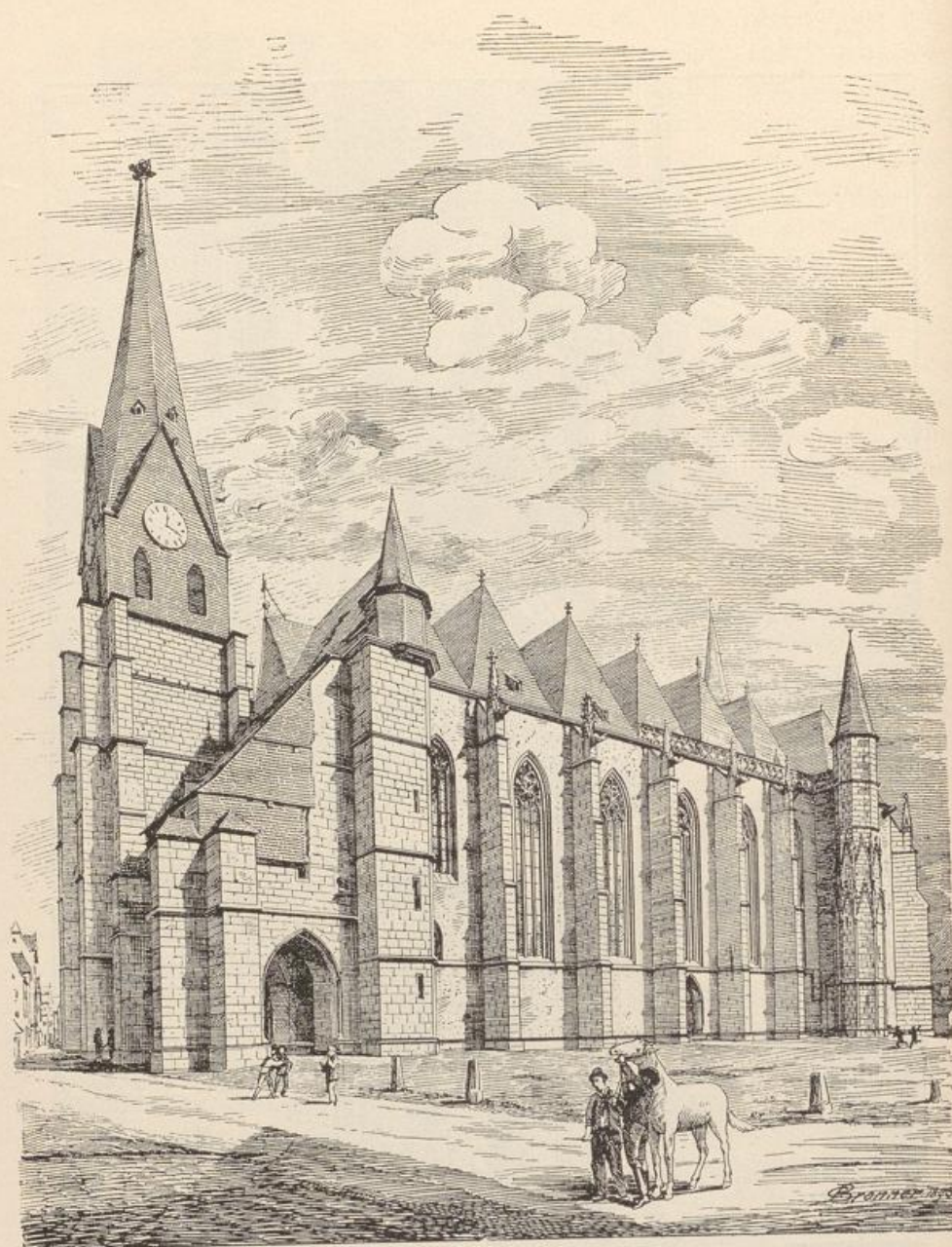
Fig. 48. Südseite der Stadtkirche zu Friedberg.
