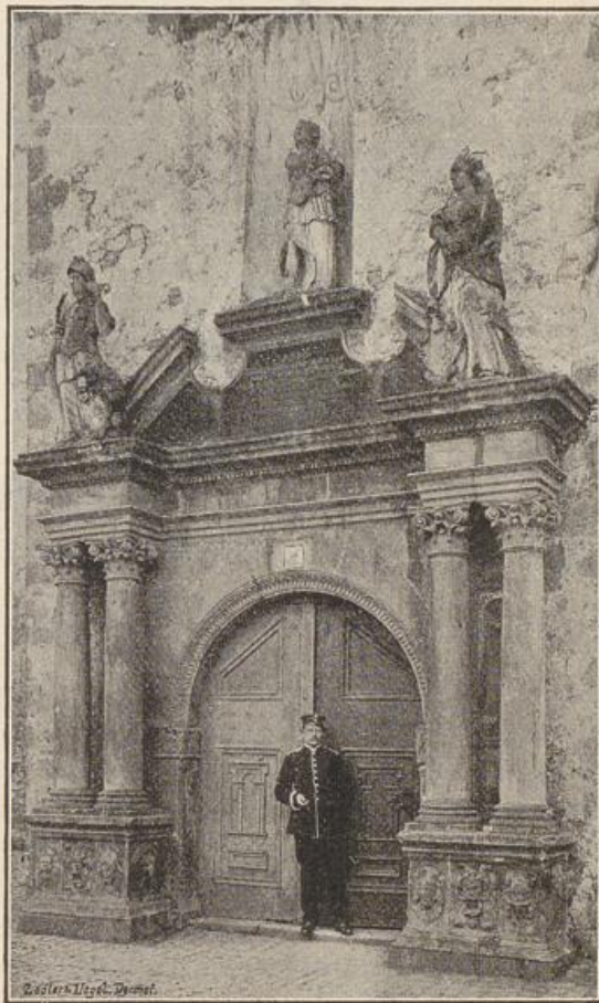
Fig. 33. Portal der Kaserne zu Butzbach.
