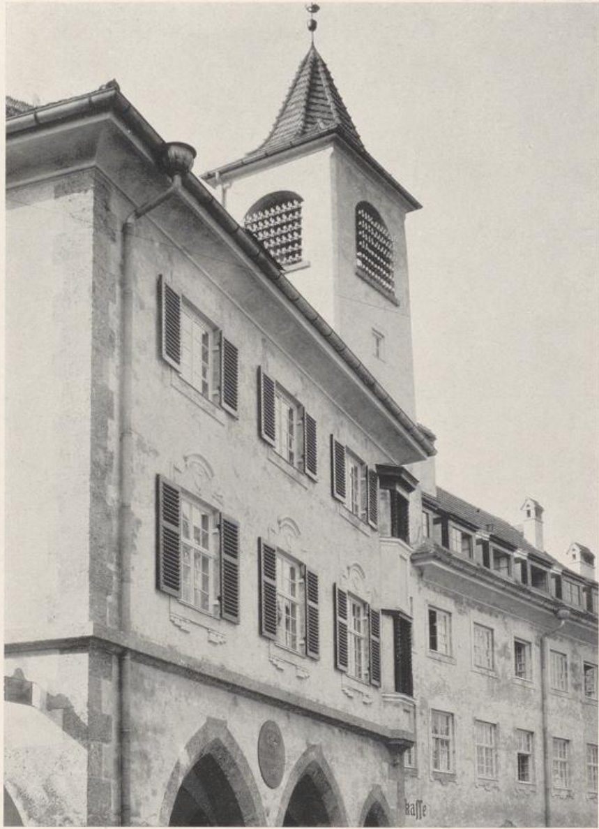
Abb. 22. Das Postgebäude (Sparkasse) in Hall (Tirol)
