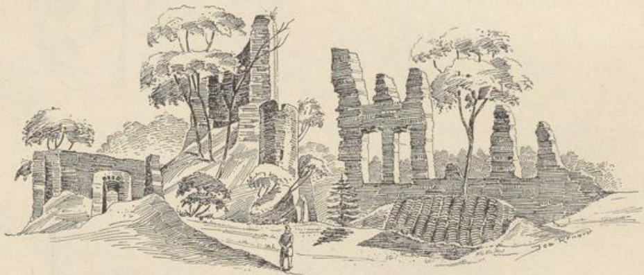
Fig. 52. Burg Windeck. Ansicht.
