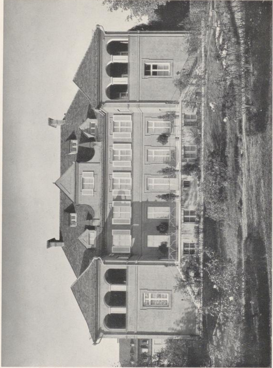
Abb. 48. Haus Adelsberger in Nürnberg. Gartenansicht
