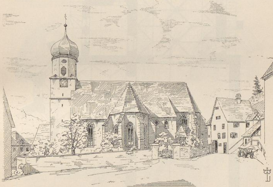
Hettingen. Äussere Ansicht der Pfarrkirche.
