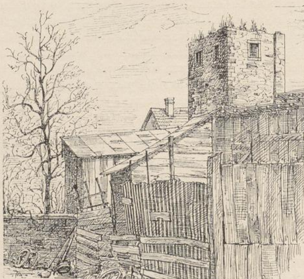
Fig. 62. Pulverthurm in Sachsenhausen.
