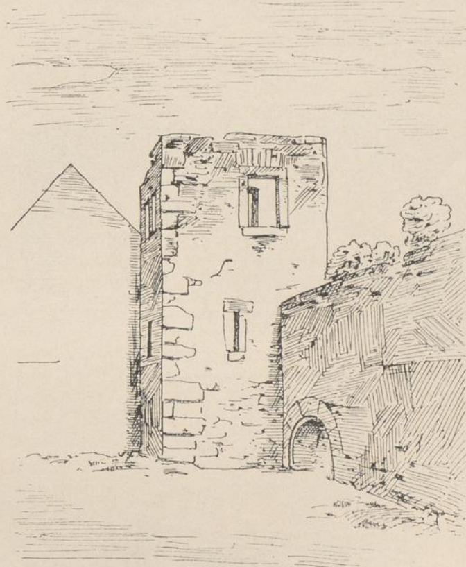
Fig. 65. Mauer-Thurm am Holzmagazin.
