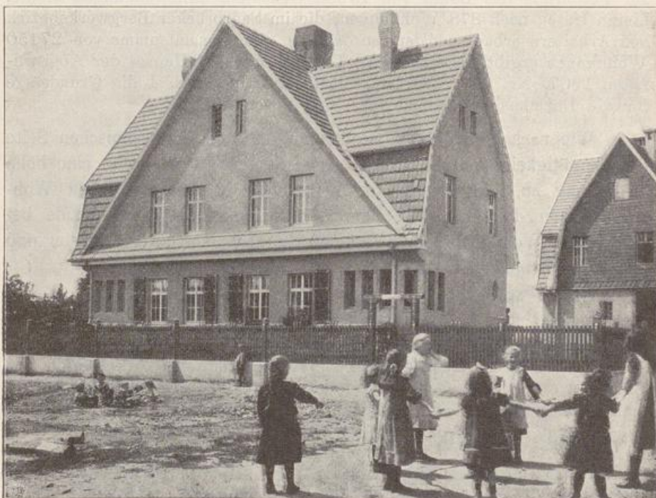
Abb. 75. Beamtenwohnhäuser im Eisenbahndirektionsbezirk Kassel.
