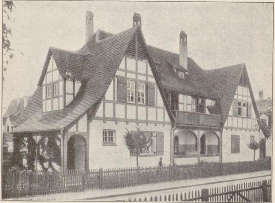
Abb. 107. Arbeiterwohnhaus der Siedelung Gmindersdorf.
