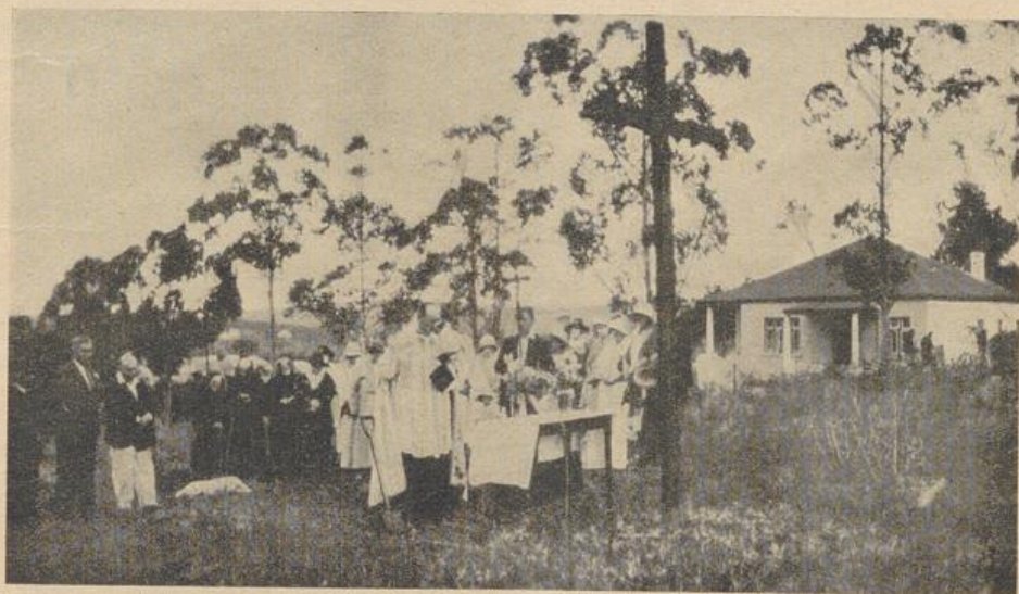
P. Otto Grimm RMM. segnet den Bauplatz für die neue Kirche Christus König in Butterworth und tut den ersten Spatenstich am Christkönigsfeste
