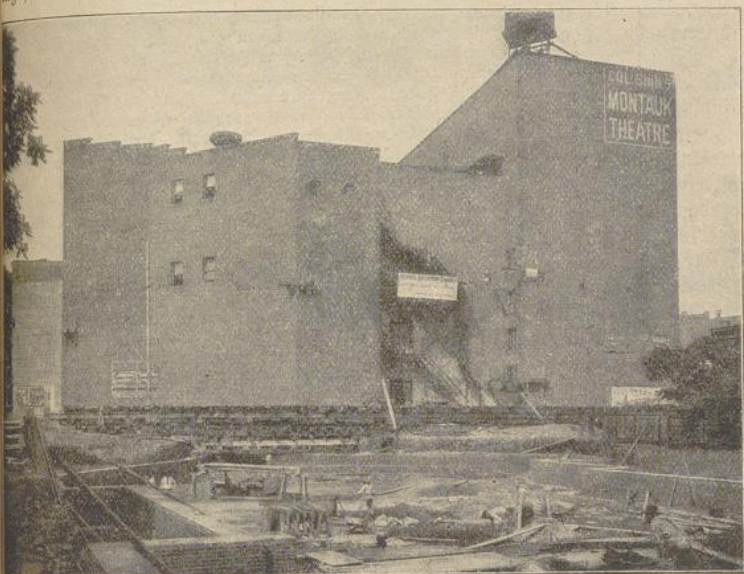
Ein Meisterwerk amerikanischer Technik: Die Versekung des Montauk-Theaters in Brooklyn.
