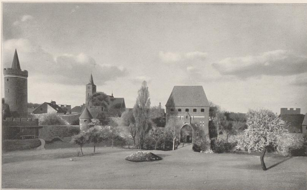
Bernau, An der Stadtmauer.
