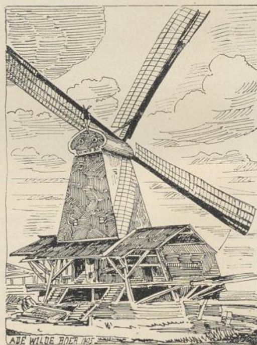
Abb. 325. Schneidemühle in Zaandam.
