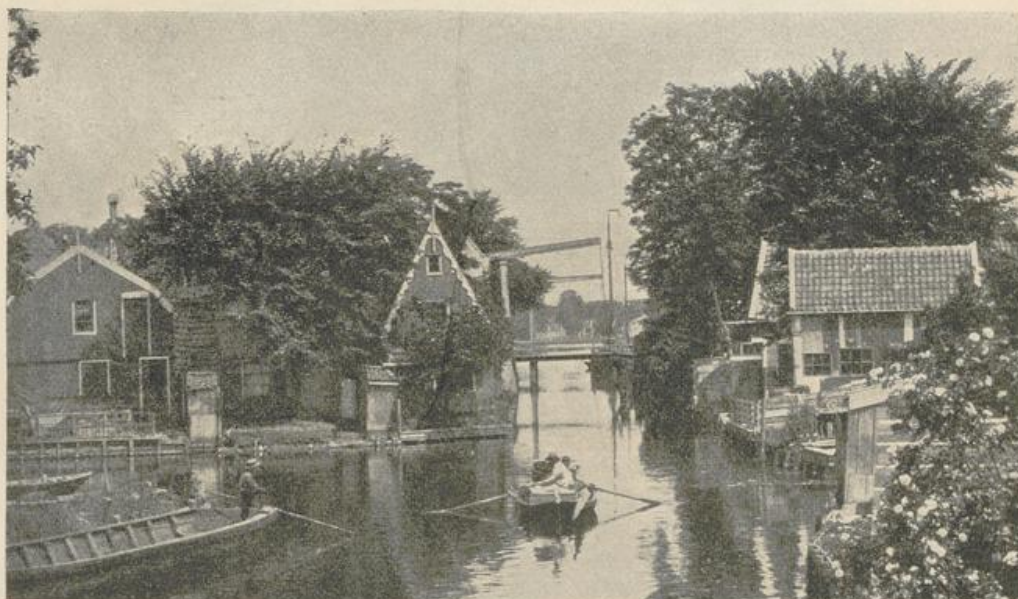
Abb. 323. Kanal bei Zaandam.
