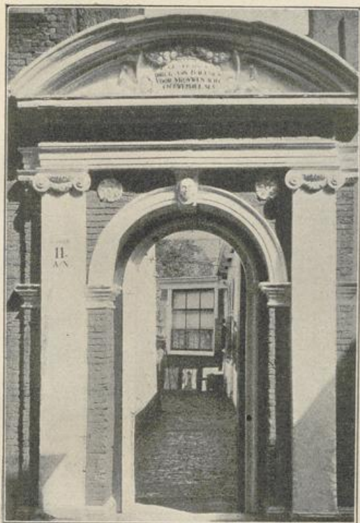
Abb. 300. Backenes Hofje in Haarlem. Portal an der Straße (1628).
