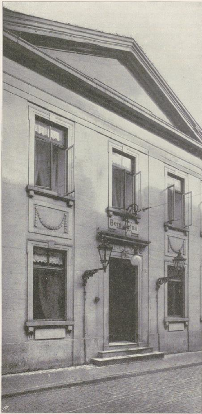
(1810) Abb. 47. Hotel Dütting, Domhof-9 (Mittelteil). L
