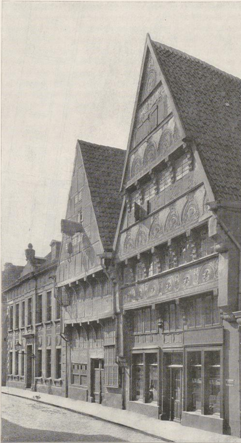
Abb. 62. Blick in die Kranstraße mit den Häusern Willmann (No. 7) und Schwartze (No. 8—10) (Aufnahme der Meßbildanstalt).
