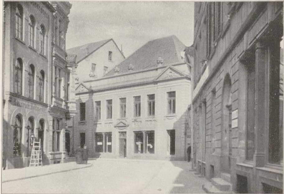
Abb. 50. Haus Wessell, Großstraße 24/25.
