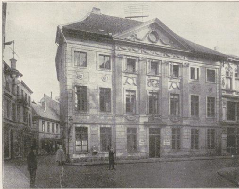
1797 Abb. 43. Die Hirschapotheke vor dem Umbau von 1907. L
